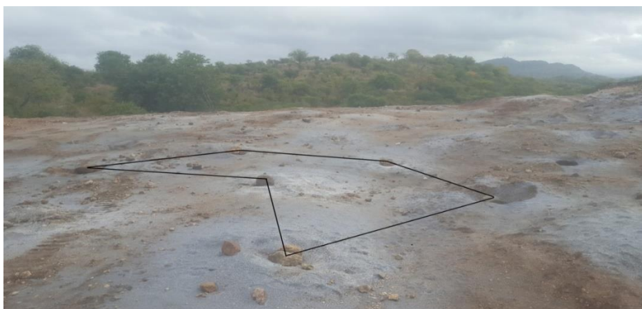
Figura 5: Tipo de malha e o tampão após a perfuração
